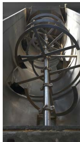
Detalle del interior de la tolva
